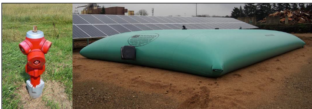
Figure 18 : Borne incendie (à gauche) et réserve incendie (à droite)
