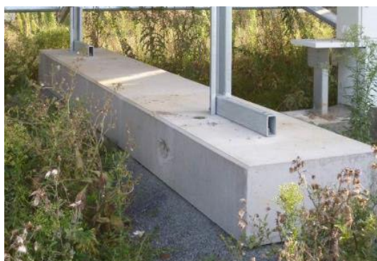
Figure 7 – fondation - semelle béton
