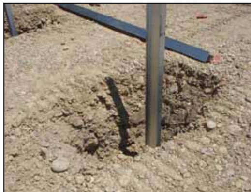
Figure 6 - ancrage par pieux battus
