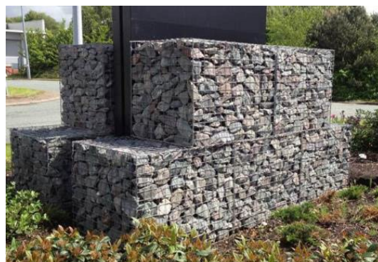
Figure 8 – Exemple de muret en gabion
