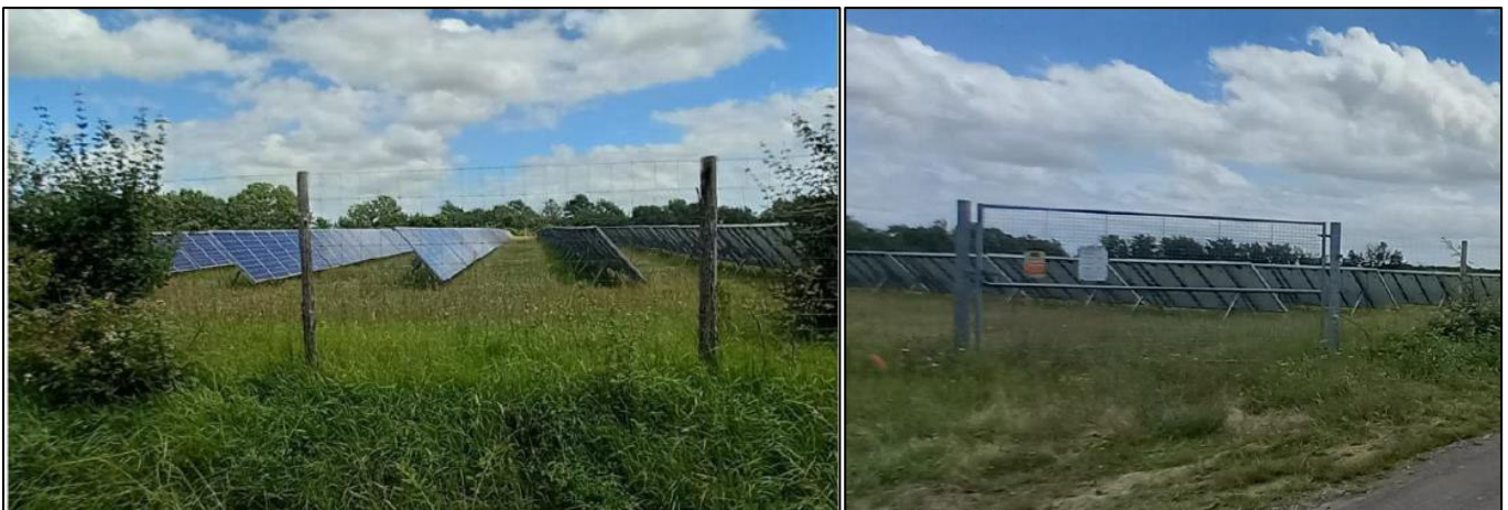
Figure 16 : Exemple de grillage et portail d'accès
